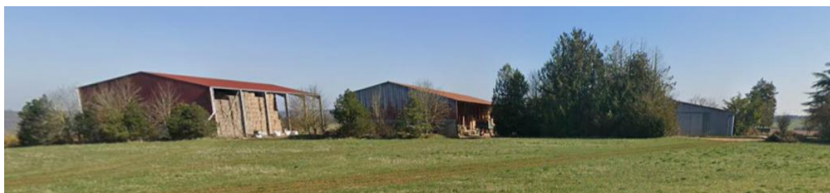
Exploitation Rue de Prenois
