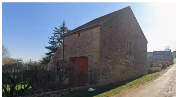
1 logement rue du Dieu de la Pitié
